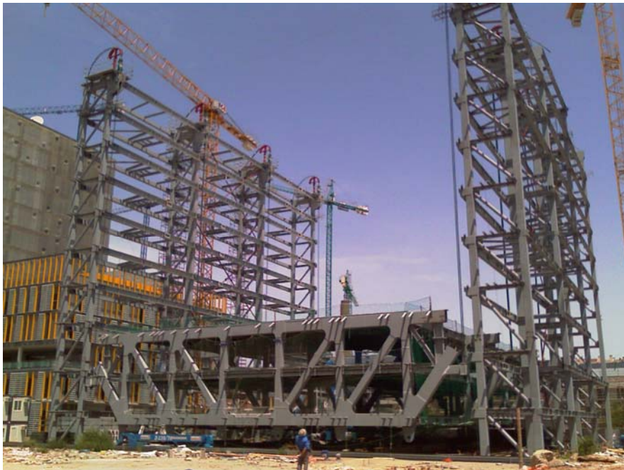
Fig. 2. Muntatge de la jàssera de suport
