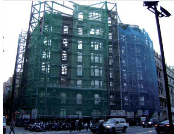
Estado posterior de la fachada del edificio
