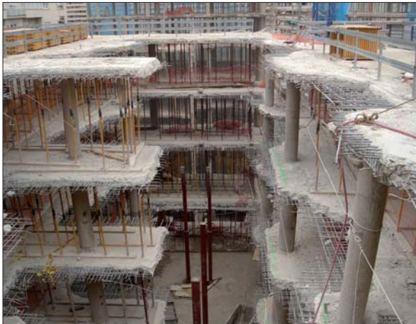
Complejo derribo para realizar los patios interiores
